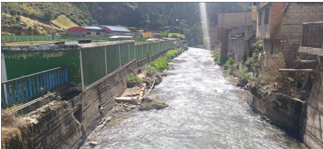
FIGURA N°02: Final de tramo crítico, canalizado con muros de contención en ambas márgenes, mostrando acumulación de material en el lecho y algunos daños en las estructuras,
