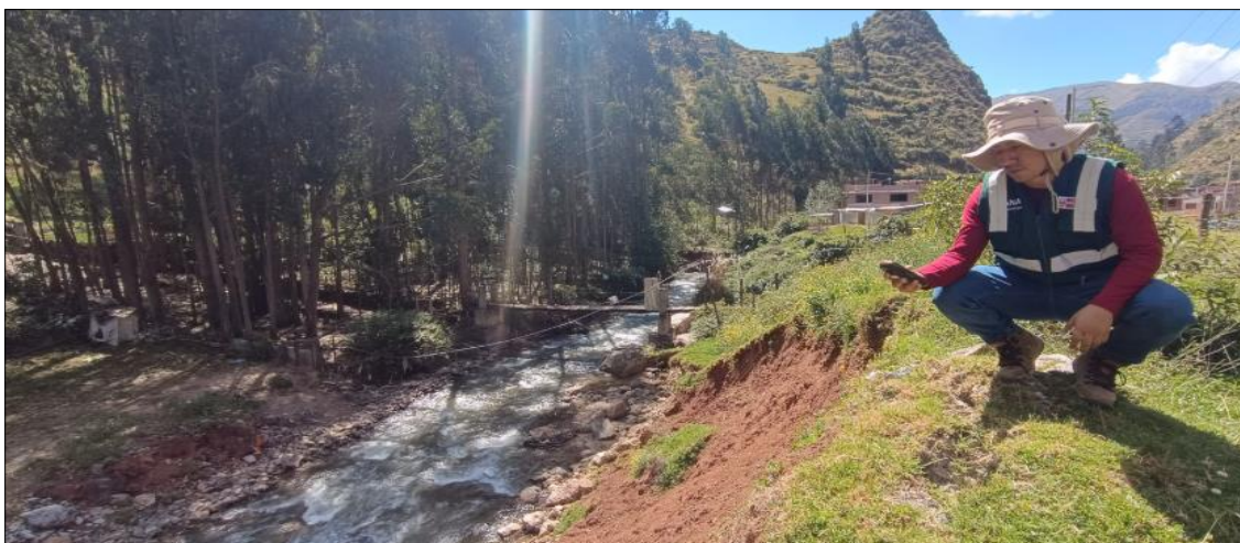
FIGURA N°01: Vista del Río Huallaga con flujo activo y una margen inestable mostrando erosión severa y socavación, donde una persona evalúa el terreno. Se observa vegetación
